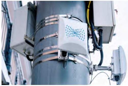
Mobilfunkmast mit 5G-Sender
